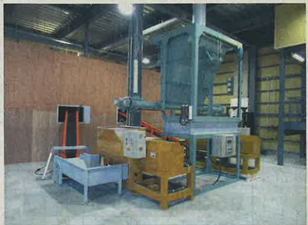
固化剤の投入・混練固化装置
